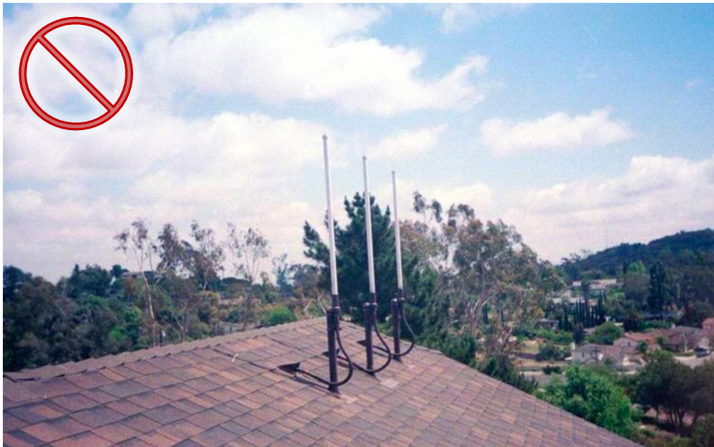
Bič antena je zaklonjena TV-antenom
