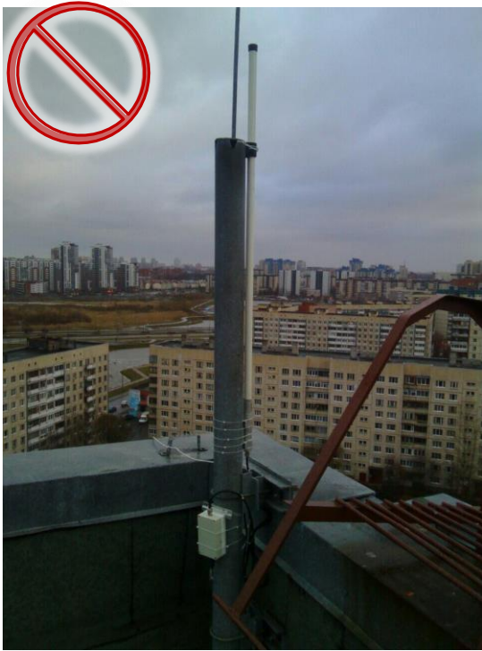
Bič antena zaklonjena tornjem i instalacijama.
