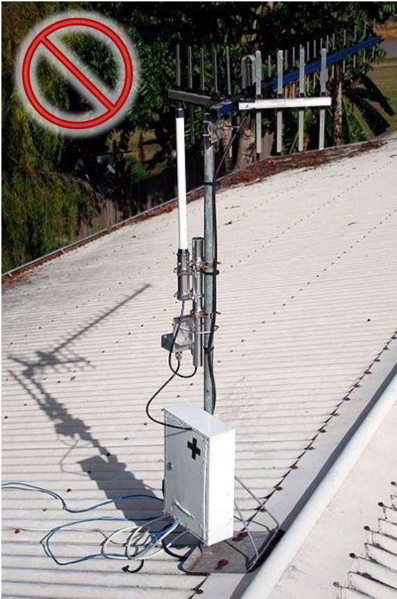
Bič antena je zaklonjena TV-antenom
